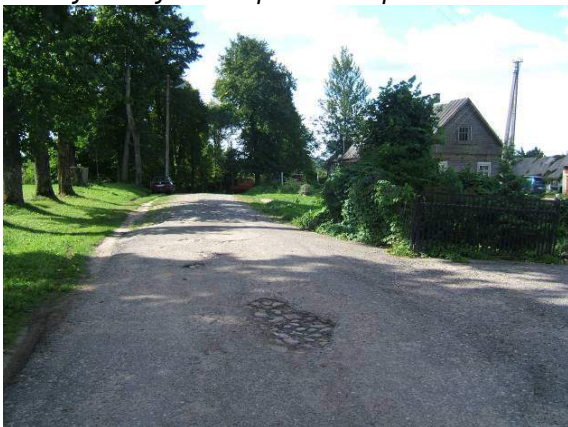
1.1.14 pav. Aikštės ir gatvių grindinys užlietas asfaltu
